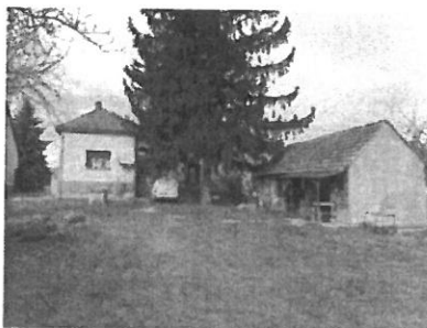
A lakóház az udvar felől
